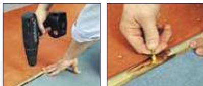
Perçage pour vis tête fraisée bombée Ø 3,5 mm.
