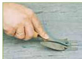
Pré-arasement avec le guide d'arasement lorsque le cordon sera froid, on réalisera l'arasement définitif avec le couteau quart de lune uniquement.
