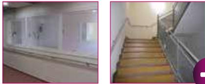
L'escalier quelle que soit sa conception d'une largeur  $\geq 1,20$  m, doit comporter une main courante de chaque côté.
