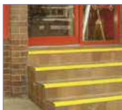
Les nez de marche sont idéalement à percer à 50 mm de chacun des côtés puis à environ 30 cm d'intervalle. L'opération peut être complétée par le rajout de mastic colle MS polymère MS Express réf 93021. Profils non percés.
