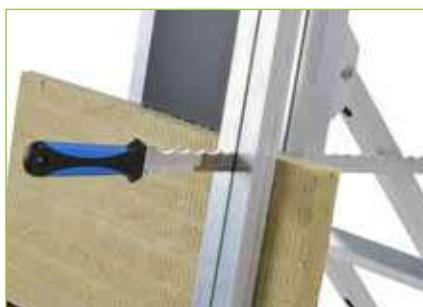
Le matériau est bloqué par pression du cadre alu pour faciliter la coupe au couteau multi-matériaux ou à la scie sabre.
