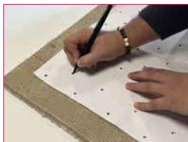
1 - Positionner le gabarit papier sur le dos de la moquette afin d'y marquer au crayon les emplacements des clous.
