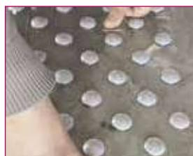
3- Les fixer au sol grâce à la bande adhésive positionnée sur le gabarit à cet effet.
