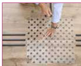
1- Positionner les gabarits en les clipsant entre eux (encoche prévue sur le gabarit transparent)
