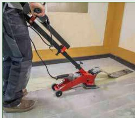
Déposer en poussant à fond sans brutaliser la machine. (Ne pas s'en servir comme un grattoir). Maintenir la lame suivant un angle de 30° et jamais à plat.
