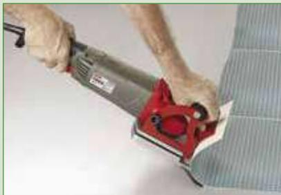
Dépose d'un lé de PVC
