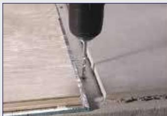
1- Avant la pose du revêtement, tracer une ligne et percer le nombre de trous souhaités (5/m) en utilisant un foret de Ø 6 mm.
