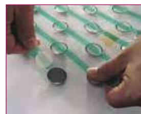
2- En effet, il suffit de tirer sur les bandes vertes pour qu'en quelques secondes les protections des adhésifs de chaque clous soient retirées.
