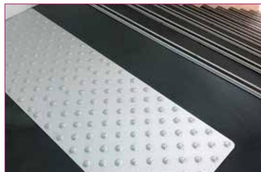
Dispositif tactile et visuel destiné à alerter les personnes aveugles et malvoyantes d'un danger imminent sur leur cheminement. Dalle esthétique en inox brossé 304, tôle épaisseur 1,5 mm emboutie, grain 220 antidérapant. En plus de la fixation par vis, appliquer des cordons de colle polyuréthane en zigzagant afin d'atténuer les bruits «clac-clac» lorsqu'on marche dessus. 6 Trous percés-fraisés Ø 3,5 mm pour fixation par vis inox 35 mm non fournies. Poids : 6,5 kg
