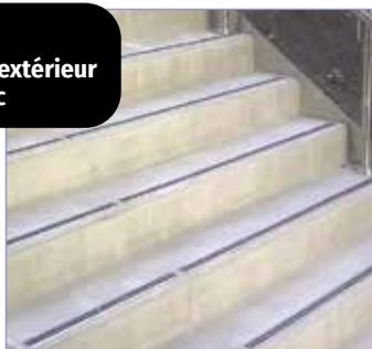
Nez de marche aluminium avec insert de 1,5 mm d'épaisseur de résine coulée de méthacrylate et de granulats de marbre. Grande résistance à la corrosion. Haute performance d'anti-glissance. Facilité de pose. Les charges antidérapantes sont encapsulées par un vernis protecteur non jaunissant pour une meilleure tenue et éviter le rejet. Sur enrobé ou sur béton extérieur, appliquez au préalable le produit ACTISOL.
